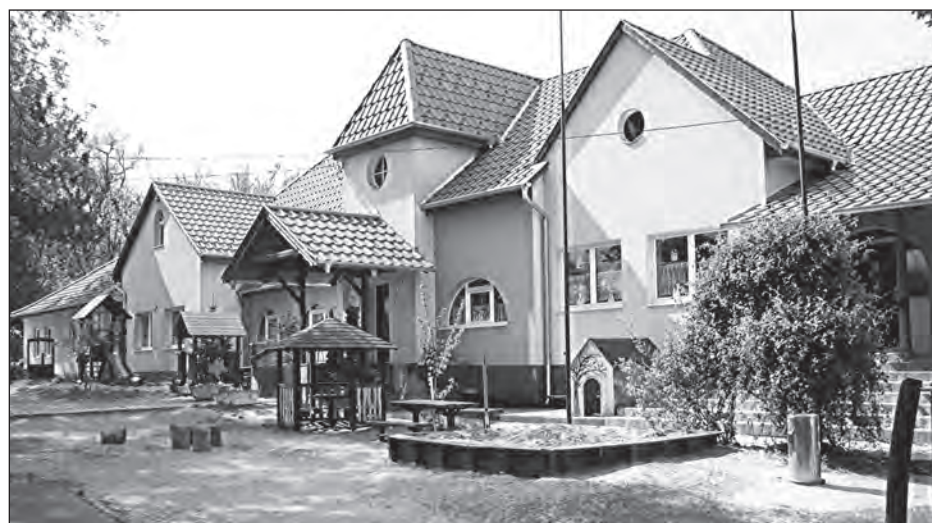
Az óvodában megtörtént a tetőszerkezet felújítása és a héjazat cseréje, a fűtés korszerűsítése
